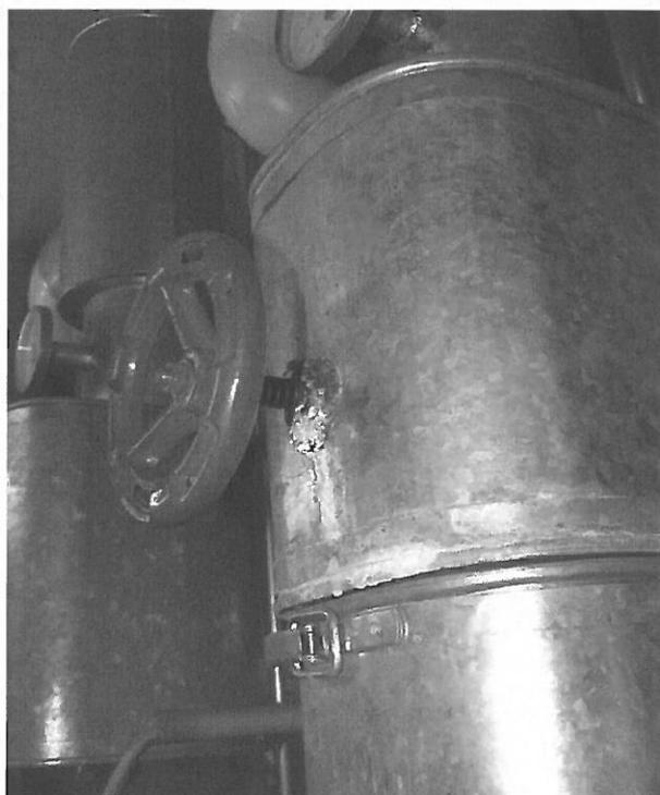
Bild 4: undichte Absperrarmatur
