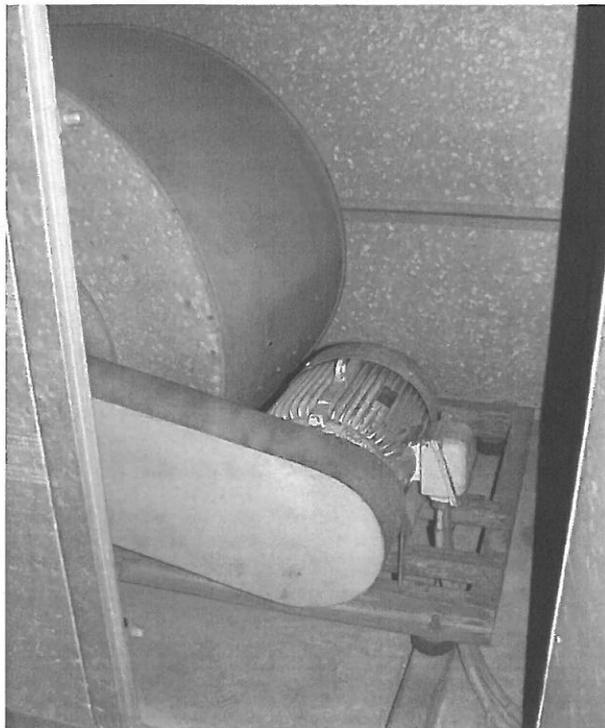
Bild 6: verbauter Typ Ventilatorantriebe (ohne stufenlose Leistungsanpassung und hohe Antriebsverluste)
