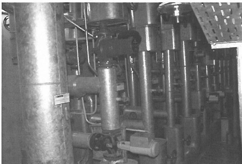
Bild 2: bestehender Verteiler mit Korrosionserscheinungen an den Ventilen
