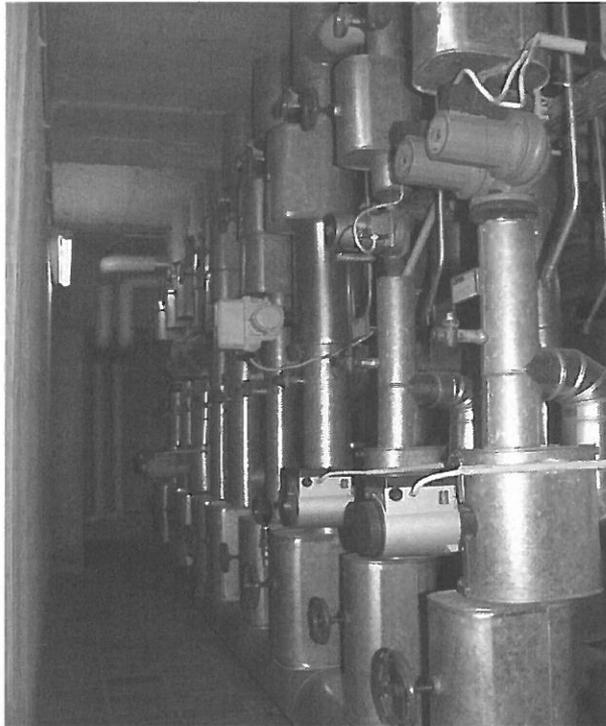
Bild 1: bestehender Verteiler mit Korrosionserscheinungen an den Verschraubungen
