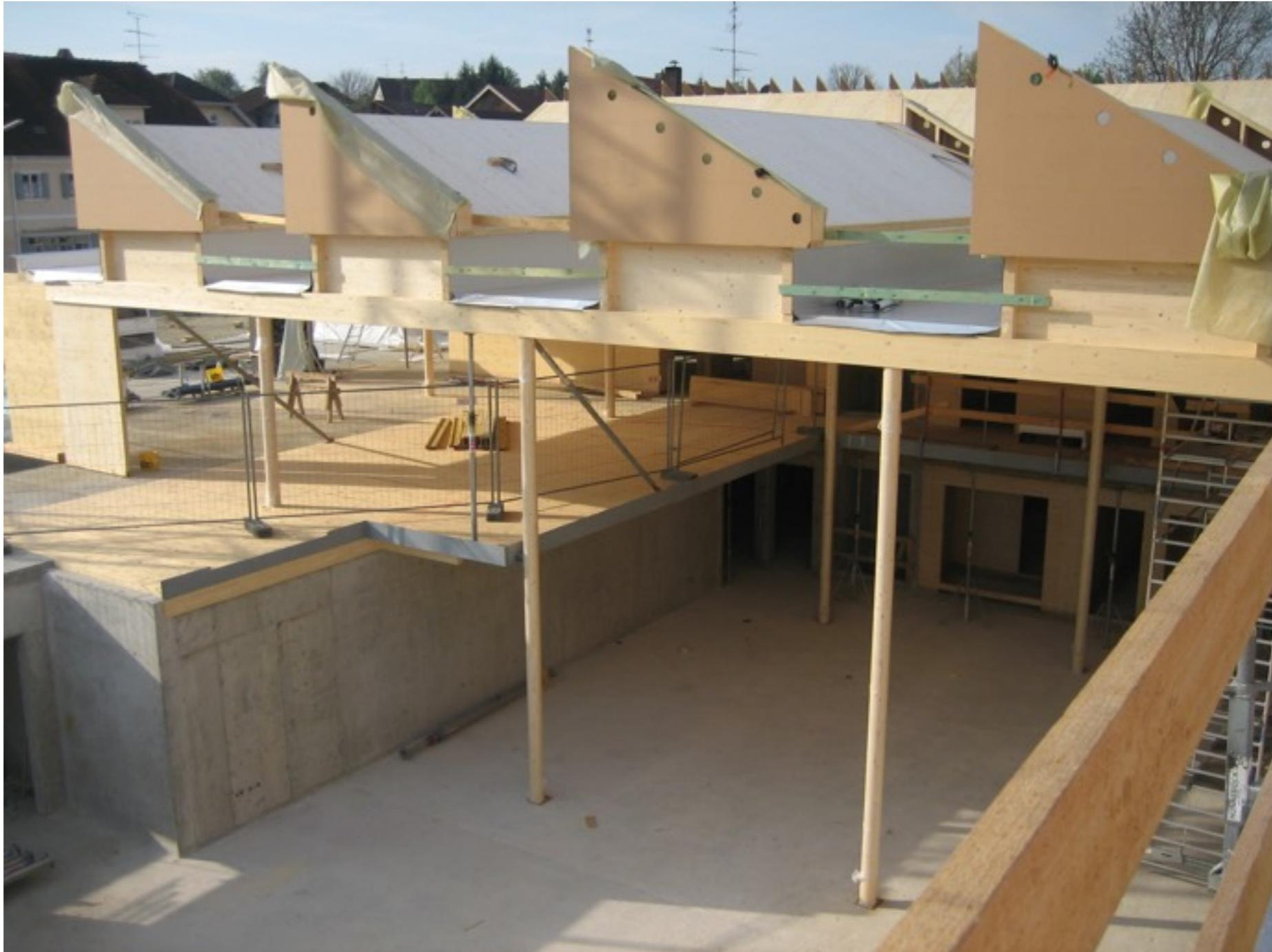
**Fertig montierte Sheddächer über der Pausenhalle
