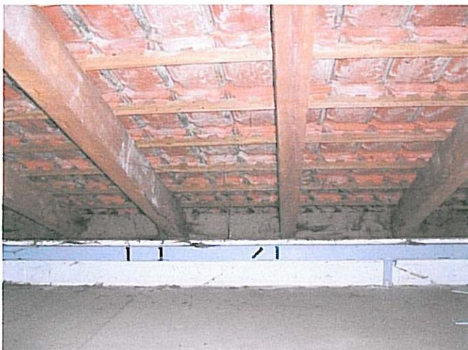
Bauteile A (ungedämmtes Satteldach)
