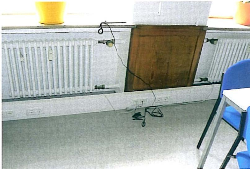
Bild 7: in 1986 ausgetauschte Heizkörper mit Thermostatventilen (Durchgangsventil)
