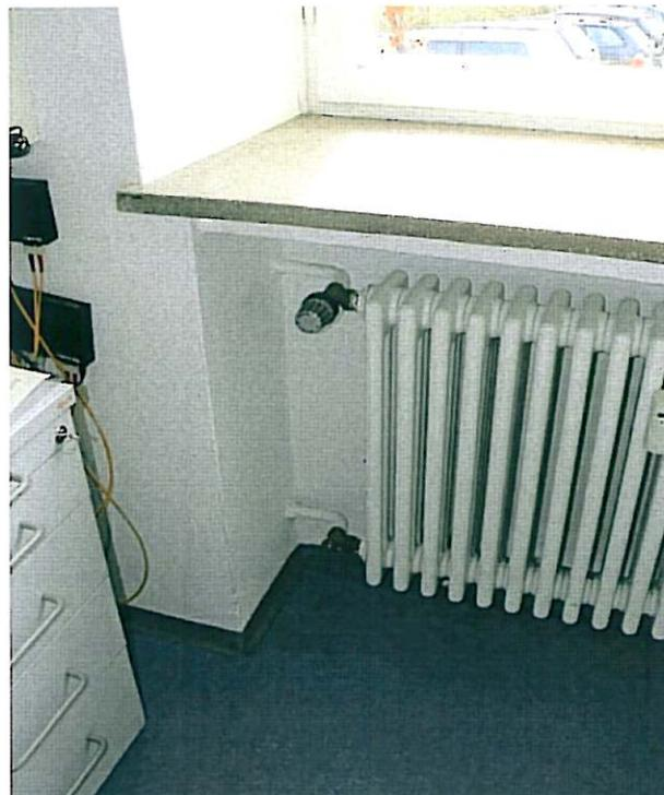
Bild 8: in 1986 ausgetauschte Heizkörper mit Thermostatventilen (Eckventil)
