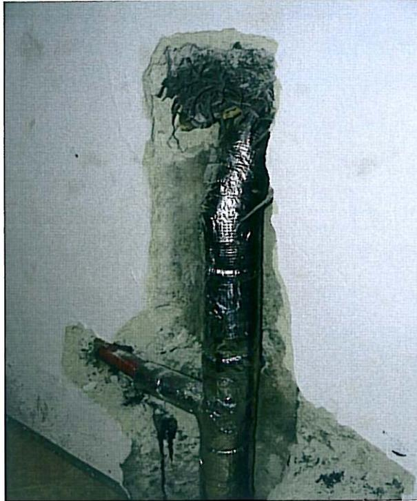
Bild 3: nachträglich ausgetauschte, jetzt isolierte, Leitung in der Aussenwand
