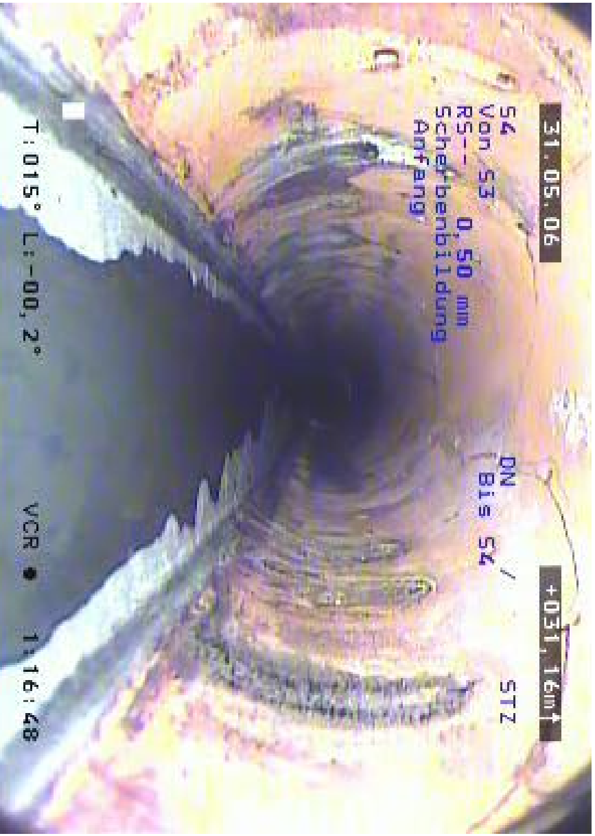
Bild 1 und 2: Scherbenbildung im Steinzeugrohr
