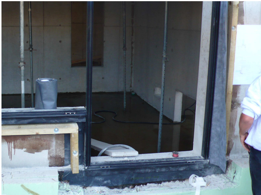
Abbildung 2: Musterfassade (während Einbau)
