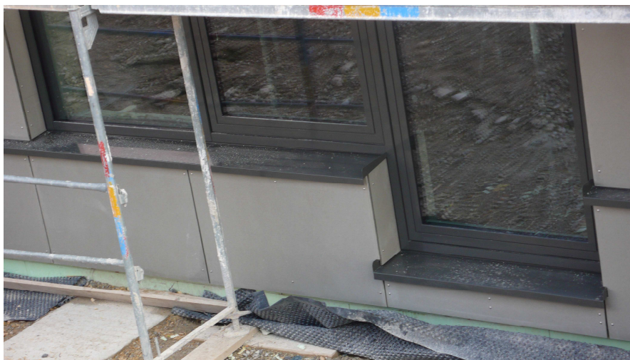
Abbildung 3: Musterfassade (nach Einbau)
